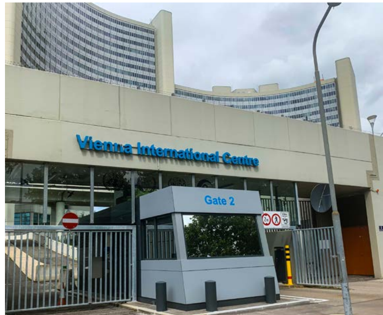
在维也纳国际中心2号门处新建的检查站
