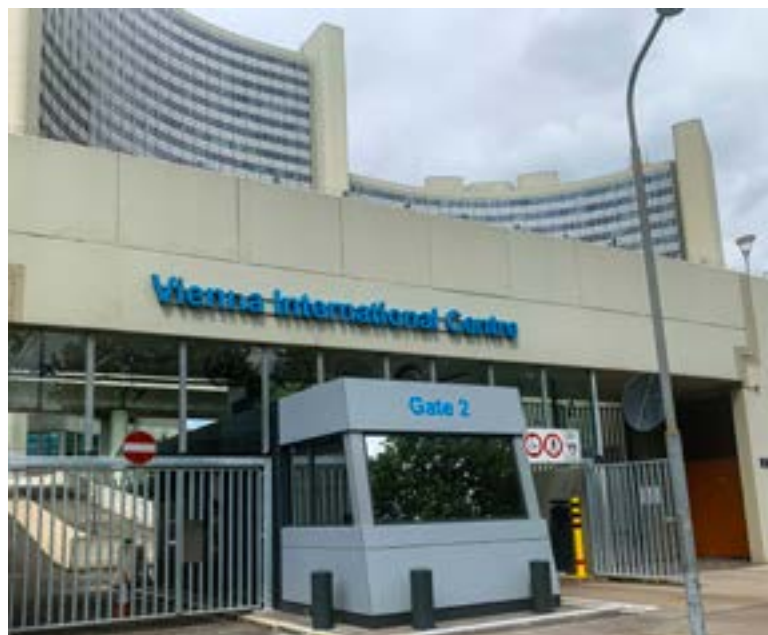
Недавно построенный контрольно-пропускной пункт на КПП 2 ВМЦ
