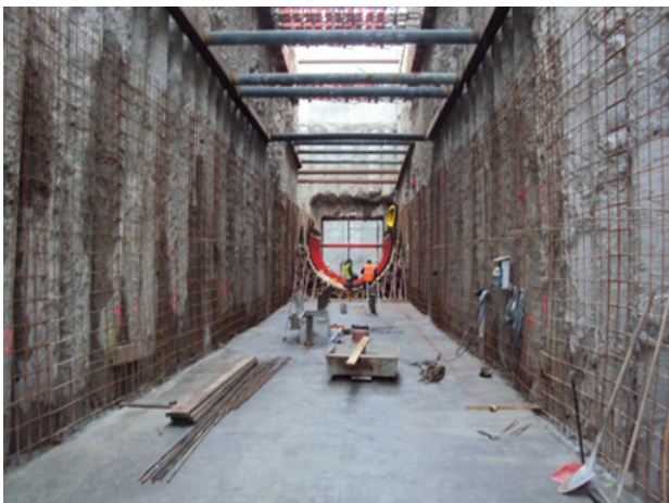
(d) formwork of the lower semicircle
