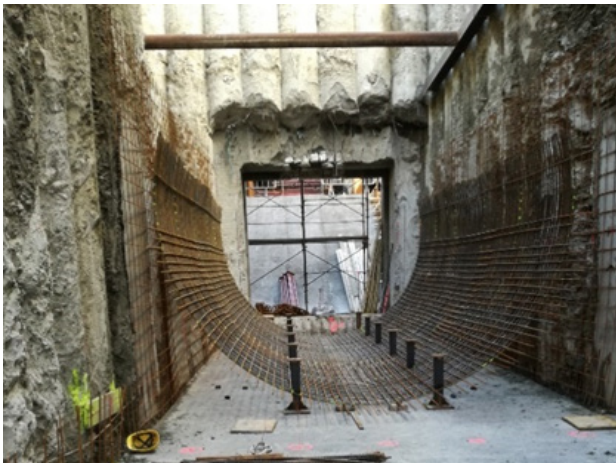
(d) formwork of the lower semicircle
